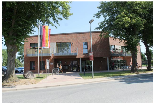
Mehrgenerationenhaus Blowatz (Bild: Monika Seitz)
