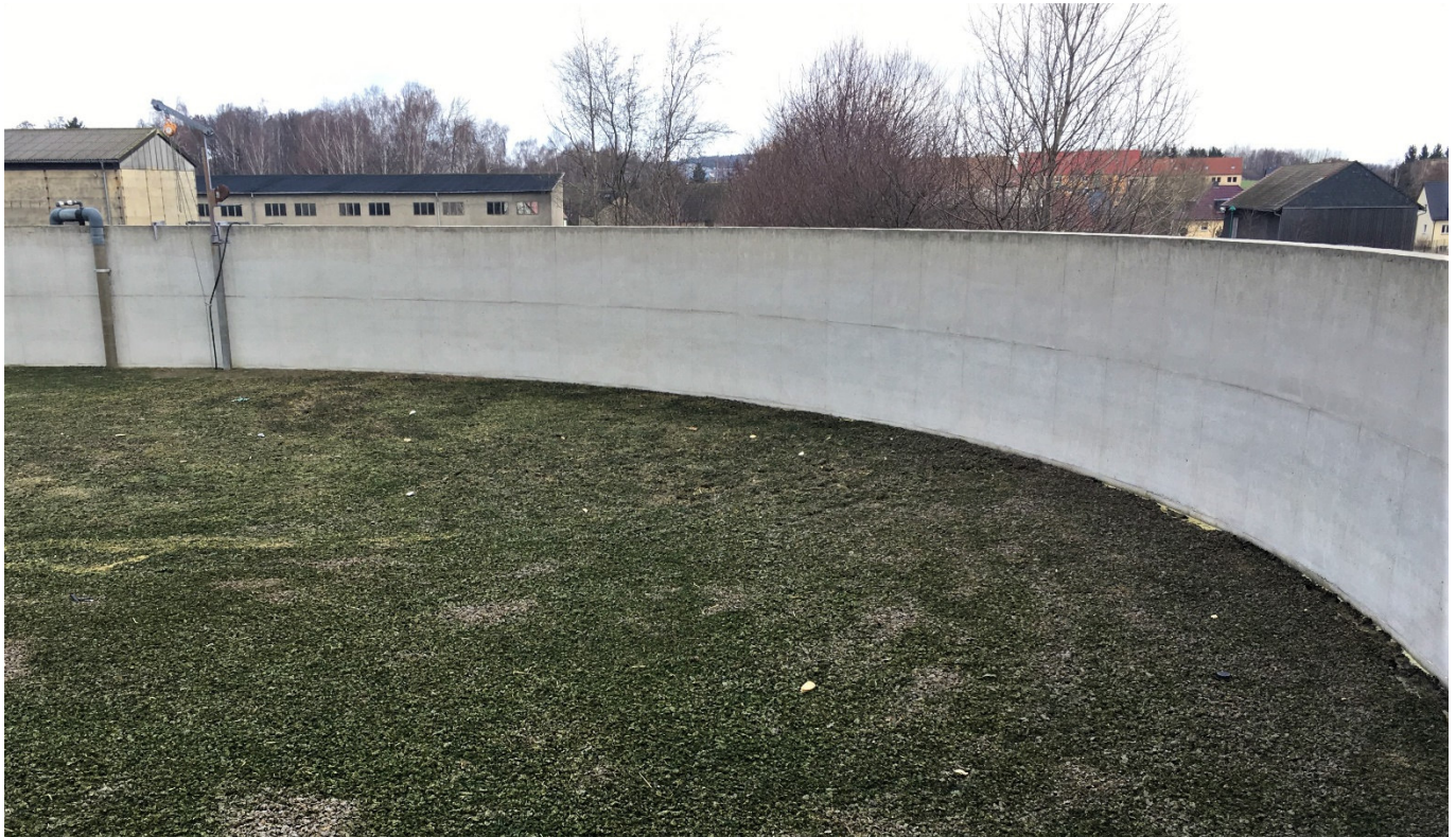
Abbildung 1: Beispiel einer geschlossenen, windstabilen Schwimmschicht mit einer Dicke von etwa 10 cm (Foto: HARZER; et al., 2024)
