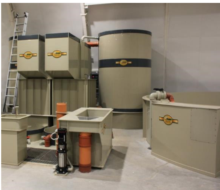
Abbildung 1: Neu gebaute Kreislaufanlage für Störe in Litauen (Nähe Simnen). Foto: Iff
