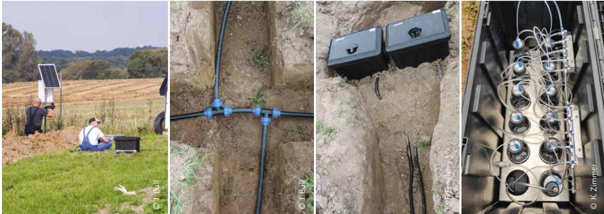
Abb. 3: Zentralstation mit Solarpaneel (links); Unterdruckleitung im Graben (Mitte links); Sammelkisten mit Druckleitung (Mitte rechts); geöffnete Sammelkiste mit über eine Hahnenbank an die Druckleitung angeschlossenen Sammelflaschen (rechts)
