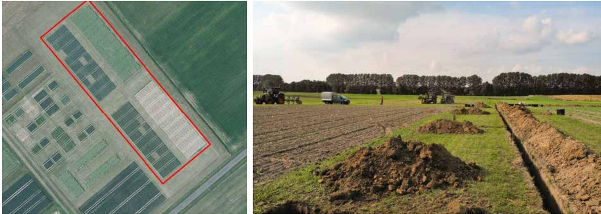
Abb. 1: Luftbild der Versuchspartellen in Gülzow (links, GAIA-MV 2016) und Beginn der Einbauarbeiten der Saugkerzenanlage in den Versuchspartellen – Hauptgraben für die Unterdruckleitung (rechts)
