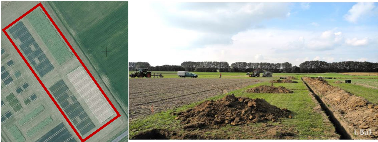
Abbildung 1: Luftbild der Versuchspartellen in Gülzow (links, GAIA-MV 2016) und Beginn der Einbauarbeiten der Saugkerzenanlage in den Versuchspartellen – Hauptgraben für die Unterdruckleitung (rechts)
