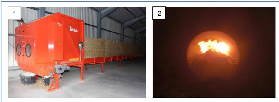
Abbildung 1 Transportband für die Brennstoffzufuhr (1) und Blick in einen Halmgutkessel (2).
