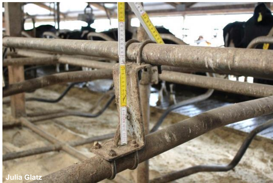
Abb. 5: Gewinkeltes Flacheisen mit Verstärkungen als Nackenrohrerhöhung
