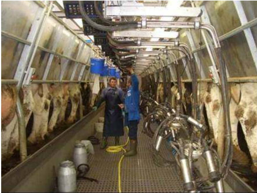
Abbildung 1: Swing Over-Melkstand
