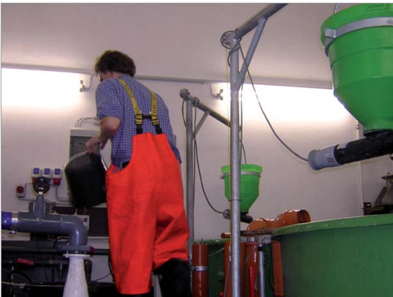
Bild 3: Arbeiten an den Pumpensicherungen – auf der rechten Seite sind die gesteuerten Futterautomaten über den Fischhälterbecken zu sehen.
