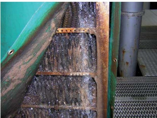
**Abb. 13:** In die Kaskade der Kreislaufanlage Hohen Wangelin eingebaute Blockelemente mit mikrobiologischem Aufwuchs für die biologische Reinigung
