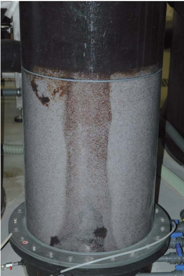
**Abb. 5:** Fließbettfilter mit Biomassepropfen
