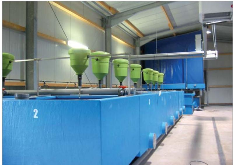
**Abb. 3: Blick in eine Kreislaufanlage für den afrikanischen Wels mit Fischbecken, Futterautomaten und Biofilter (Foto: G. Scheibe)**
